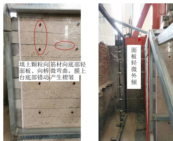
图 9 试验结束时桥台服役情况
